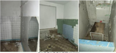
Фото 16, Фото 17, Фото 18 Объект осмотра
